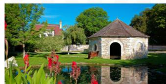
Ce lavoir octogonal a été construit en 1832. Sa toiture est portée par une belle charpente. Il est alimenté par une source dont un petit canal en pierre, la « Goulotte » conduit l'eau jusqu'au bassin. Devant le lavoir, un autre bassin appelé le « Gassou » (du patois « gassouiller » qui signifie « barboter »), construit en forme de chapeau chinois renversé, servait d'abreuvoir aux bovins et de « bain de pied » aux chevaux.
