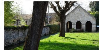
Construit en 1849, il est situé en bordure de rue. De forme rectangulaire, il porte une toiture à deux pans. Deux portes et une fenêtre à l'avant, une fenêtre côté ruisseau, toutes cintrées, en assurent l'éclairage. Alimenté en amont par une dérivation du ruisseau, le bassin rectangulaire comporte des pierres à laver sur ses quatre côtés. Une goulotte d'évacuation en pierre en fait le tour.
